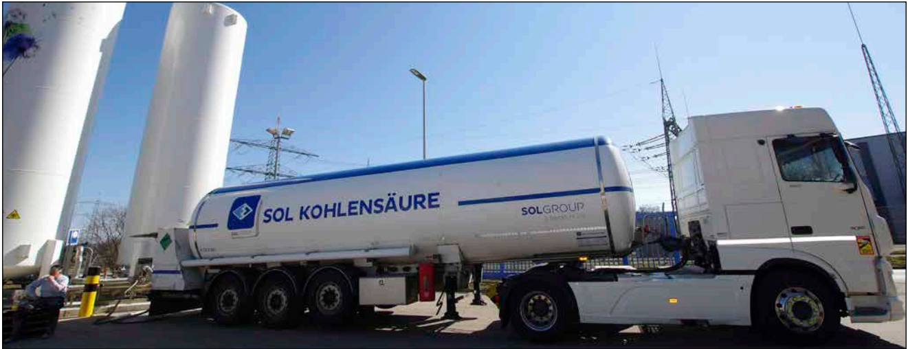
Bild 1: Lkw-Befüllanlage, links die CO 2 -Speicher.
